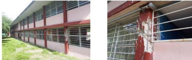
Fig. 2 Daños en columnas cortas en el sismo de 2017 en la escuela en Morelos.
